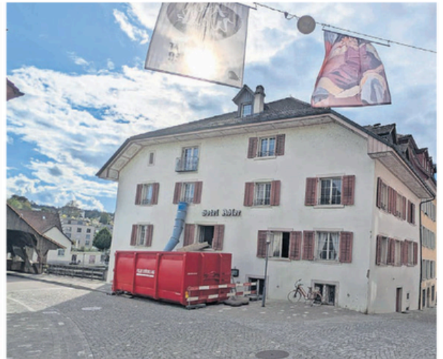
Vor dem markanten historischen Gebäude neben der alten Holzbrücke befindet sich derzeit ein Container. Tonnenweise Bauschutt wurde in den vergangenen Wochen von hier abtransportiert.
