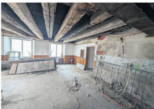
Wo früher die Restaurant-Gäste bedient wurden, entsteht ein Raum für Veranstaltungen aller Art. Insbesondere die Kultur soll hier einen Platz erhalten. Wie in zahlreichen anderen Räumen wurde die ursprüngliche Deckenkonstruktion wieder offengelegt.
