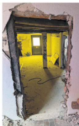
Im Gebäude wurden teilweise Türrahmen gefunden, die irgendwann zubetoniert wurden. Dieser alte Durchgang im EG wird künftig wieder einer sein.
