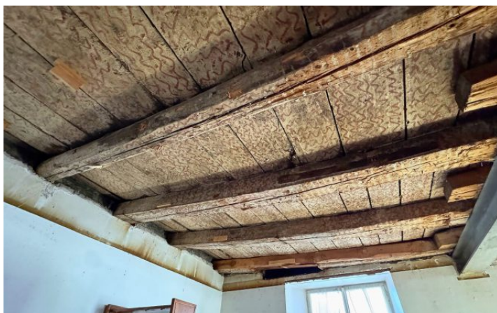
Auf den freigelegten Deckenbrettern im ersten Stock schlängeln sich rote Wellenlinien übers Holz, verziert mit Kringel und Punkten.
